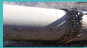
DILATACIJA T8 NA CJEVOVODU C3 HE PERUĆICA
